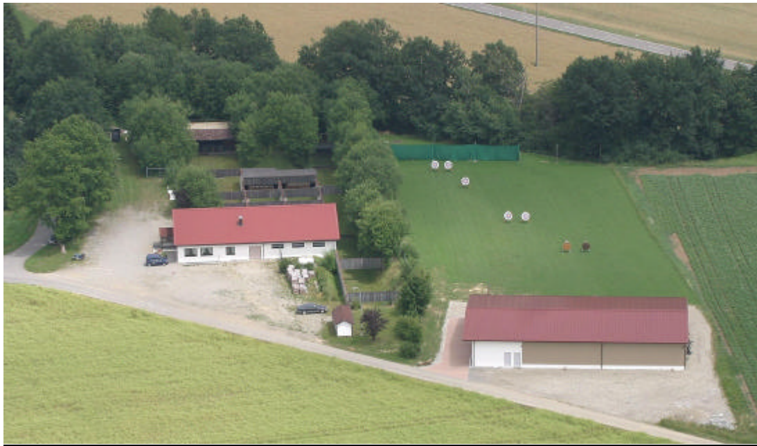
Foto: Schützenhaus links mit Bogenhalle rechts
